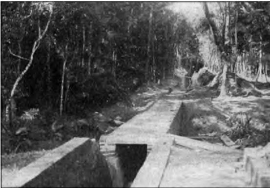
**Figura 4.** Construcción de la galería fluvial en 1942, para canalización del arroyo Pirarungáua, para la implantación de la Alameda Fernando Costa (Hoehne 1943).
