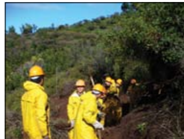
Figura 3a, b, c, d, e, f, g. Integrantes y especialistas de la Escuela de Ingenieros del Ejército, durante las faenas de construcción del primer sendero de circulación del sitio del Jardín Botánico Chagual. El camino une el futuro camino de acceso principal con el mirador central y tiene una extensión de 800 metros.
