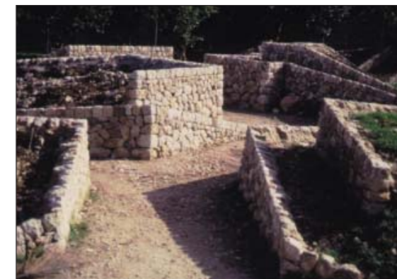
Foto 2. Construcción de volúmenes mediante muros de piedra en seco.
