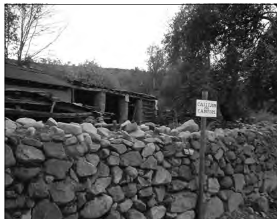
Figura 3. Pirca y construcción de piedra en el callejón Los Canelos.
